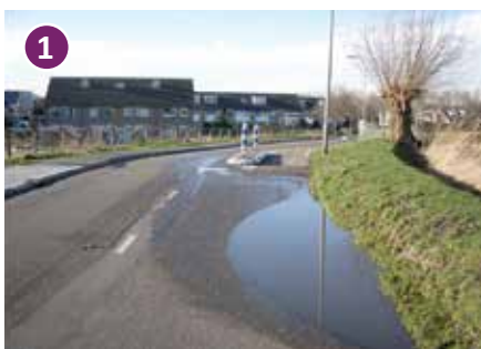
Verwijderen vluchtheuvel Grietpolderweg
