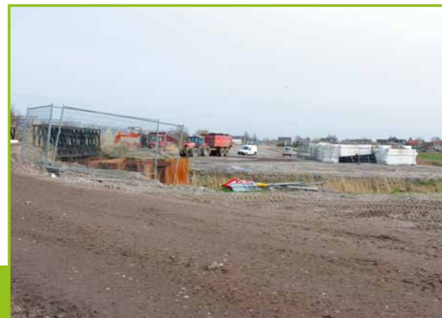
2e Brug in aanbouw
